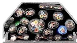
Querschnitt, Kabelkanäle
